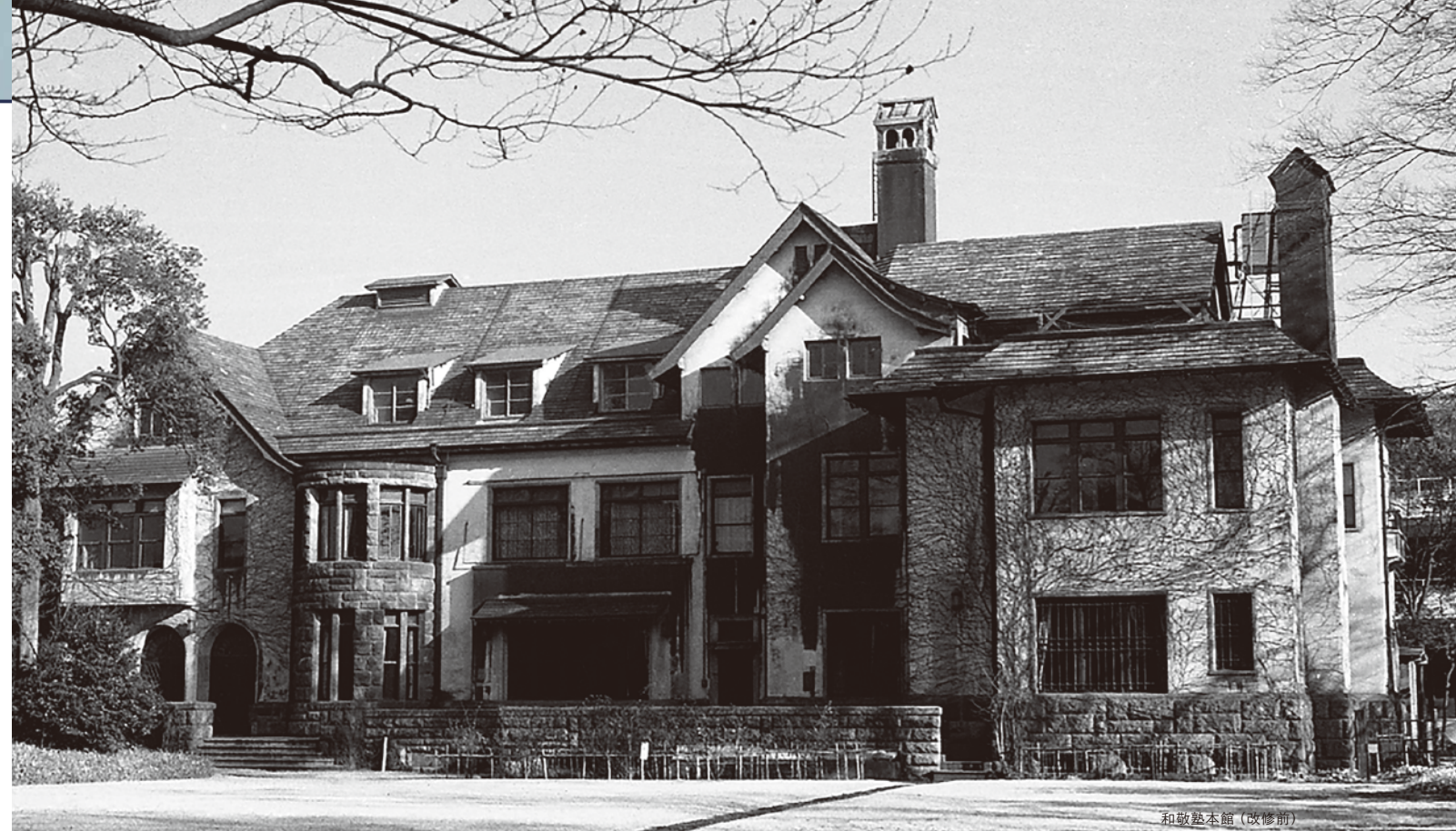
和敬塾本館（改修前）
