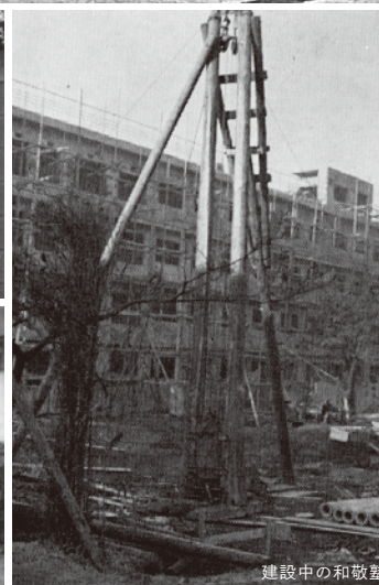
建設中の和敬塾
